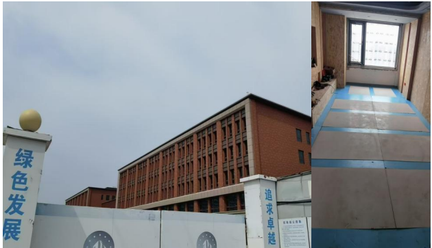
项目名称: 上海闵行区新东苑华漕国际快乐家园养老 产品：模块化地暖
